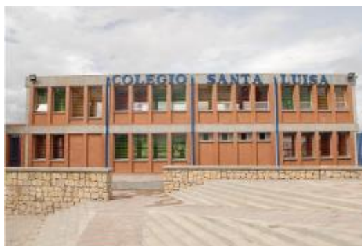
Fotografía 5.2.3.4 Colegio Santa Luisa, Kennedy Fuente: http://www.colegiosantaluisa.edu.co/
