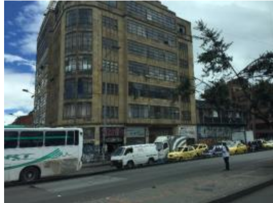
Fotografía 5.2.3.155 Edificio Barrio Santa Fe Fuente: Consorcio Metro BOG, 2017
