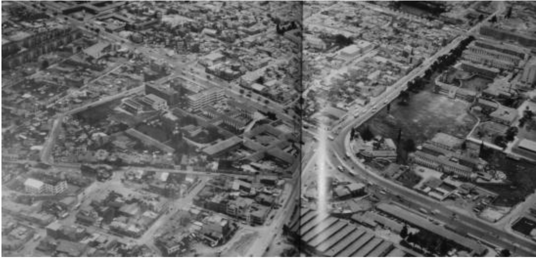
Fotografía 5.2.3.153 Cruce de la Avenida Caracas con Calle 1ª. 1947 Fuente: Bogotá, Vuelo al pasado. 2010
