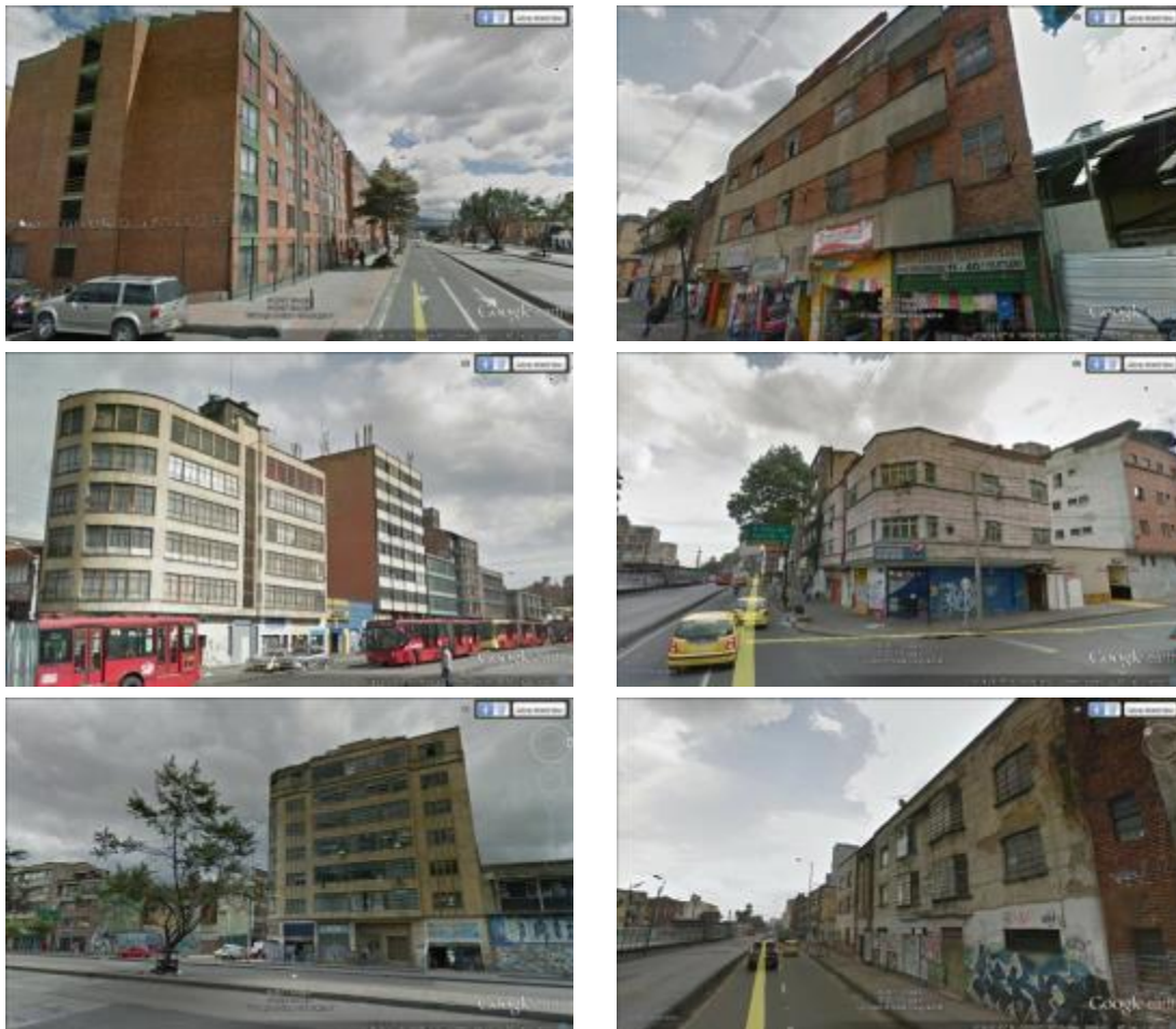
Fotografía 5.2.3.122 Viviendas ubicadas sobre la Av. Caracas, entre calles 2 y 28 Fuente: Google Earth, 2017
