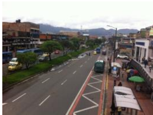
Fotografía 5.2.3.6 Av. Primero de Mayo a la altura de Plaza de las Américas. Fuente: Consorcio Metro BOG, 2017
