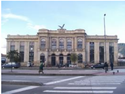
Fotografía 5.2.3.115 Estación de la Sabana
